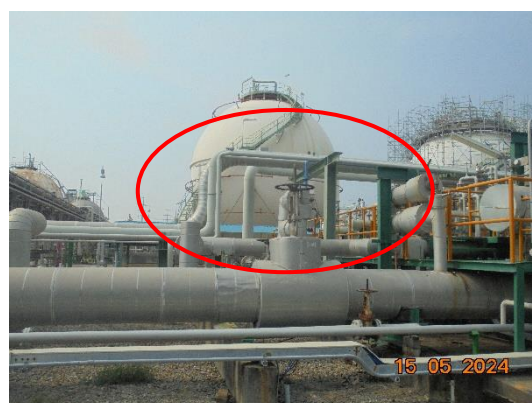
รูปที่ 2.1-31 ติดตั้ง Block Valve บริเวณแนวท่อขนส่งภายในพื้นที่โรงงาน
