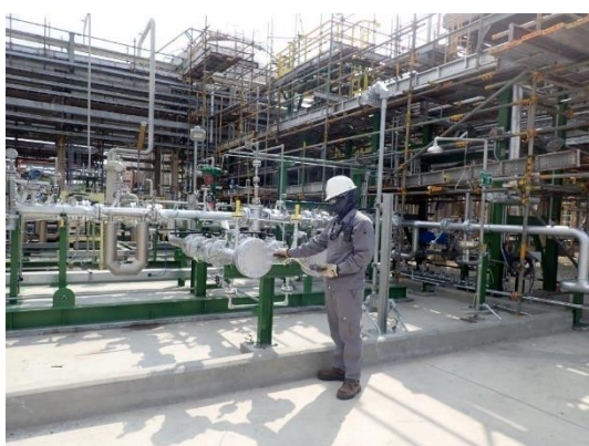
รูปที่ 2.1-32 เจ้าหน้าที่ตรวจสอบการรั่วซึม ด้วยเครื่อง Gas Detector
