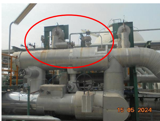
รูปที่ 2.1-31 ติดตั้ง Block Valve บริเวณแนวท่อขนส่งภายในพื้นที่โรงงาน
