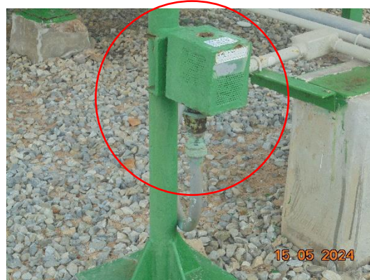
รูปที่ 2.1-33 ติดตั้งเครื่องตรวจจับก๊าซไวไฟ ภายในคั่นคอนกรีต
